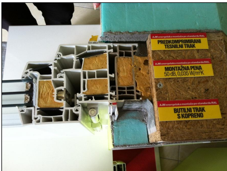
Slika 14: Primer vgradnje okna po smernicah RAL montaže s tesnjenjem okna v treh ravneh
