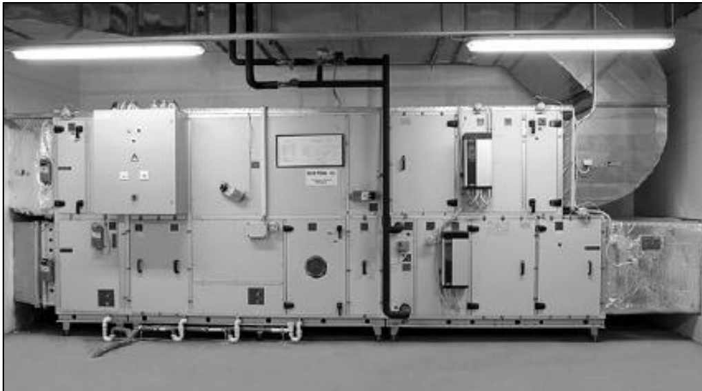
Slika 12: Modularna klimatska naprava za izkoriščanje odpadne toplote
