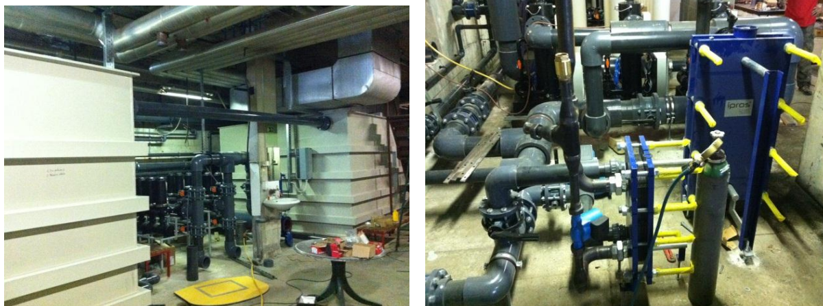
Slika 8: Nova bazenska tehnika in filtrirni sistem za bazensko vodo
