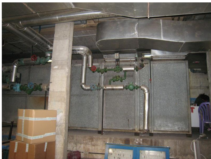
Slika 5: Dovodni klimat za garderobe
