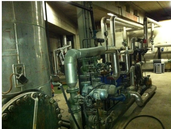
Slika 7: Toplotna podpostaja za pripravo sanitarne tople vode
